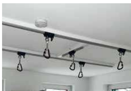
Montage auf Beton
