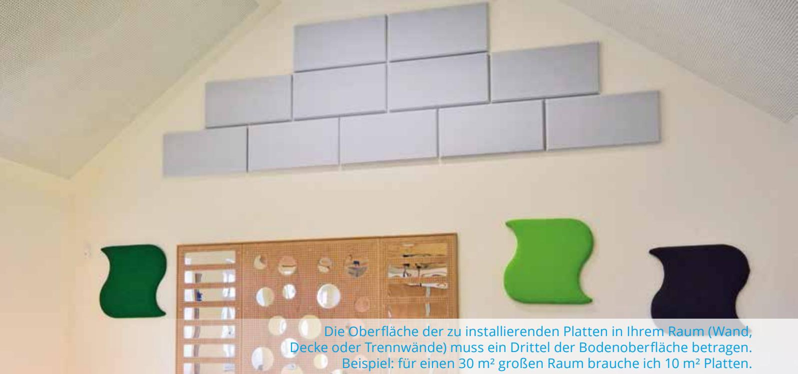
Die Oberfläche der zu installierenden Platten in Ihrem Raum (Wand, Decke oder Trennwände) muss ein Drittel der Bodenoberfläche betragen. Beispiel: für einen 30 m<sup>2</sup> großen Raum brauche ich 10 m<sup>2</sup> Platten.
