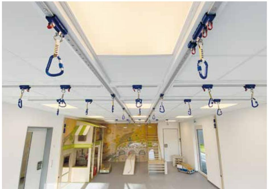
horizontales und vertikales Schienensystem
