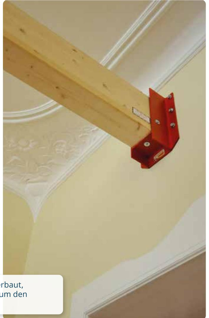
Bei dieser Montage wurde eine Balkenkonstruktion so verbaut, dass vorhandener Deckenstuck nicht beschädigt wurde, um den Denkmalschutz des Gebäudes nicht zu verletzen.
