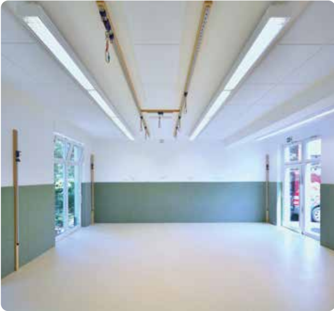
Beispiel für Akustikelemente unter der Decke
