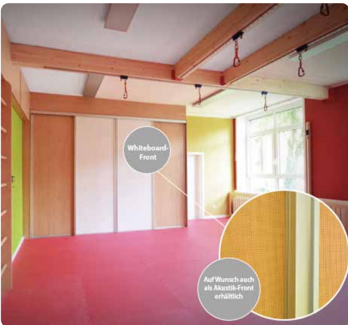
Beispiel für akustische Oberflächen in Materialschränke integriert
