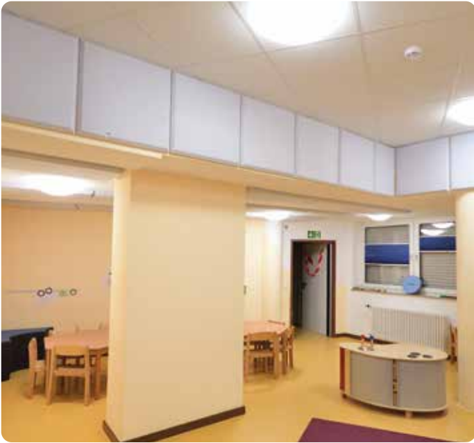
Beispiel für Akustikelemente an Deckenunterzug
