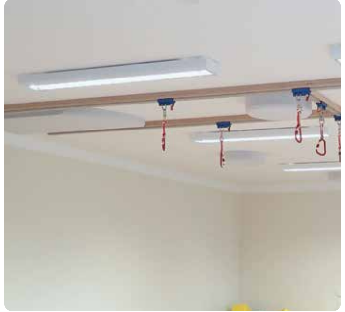
Beispiel für Akustikelemente unter der Decke
