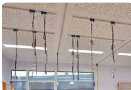
Montage auf Beton
