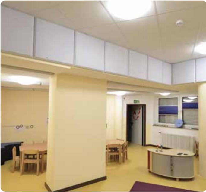
Beispiel für Akustik Elemente an Deckenunterzug
