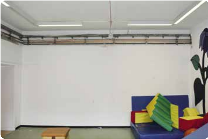
Kindergarten Wichtelhöhle, 48231 Warendorf
