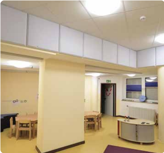
Beispiel für Akustikelemente an Deckenunterzug
